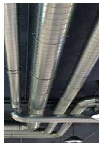
Brandschutzisolierte Doppelmantel-Lüftungsrohre (E160).
