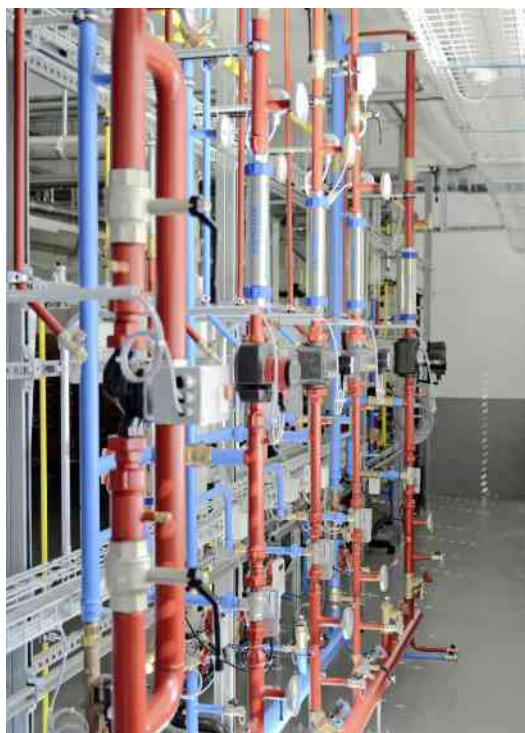
Damit verschiedenste Energiequellen zusammen mit Speichern und Verbrauchern in unterschiedlichsten Konstellationen zum Einsatz gelangen können, sind unzählige Umwälzpumpen und Ventile nötig.
